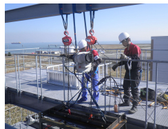
屋外テストタワー 検証設営
